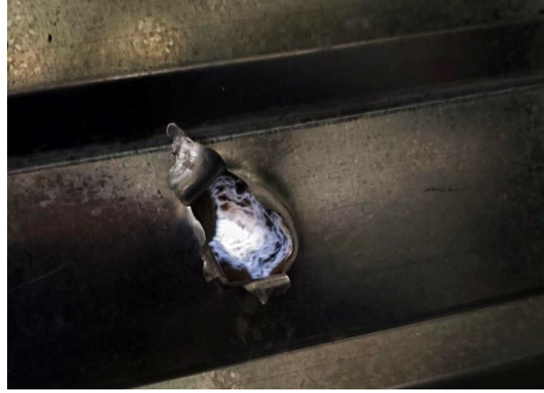
2 Die Halle zur Lagerung und Trocknung von Beeren und Pilzen wurde durch Rakentesplitter beschädigt.
