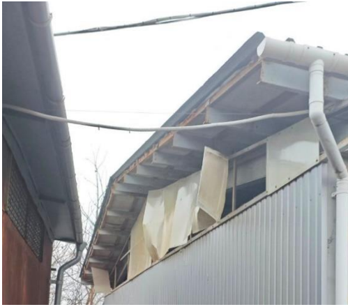
2 Die Halle zur Lagerung und Trocknung von Beeren und Pilzen wurde durch Rakentesplitter beschädigt.
