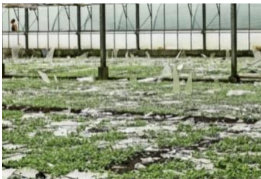
Herunterfallende Glassplitter im beschädigten Gewächshaus. (Bildrechte: Joachim Ley)
